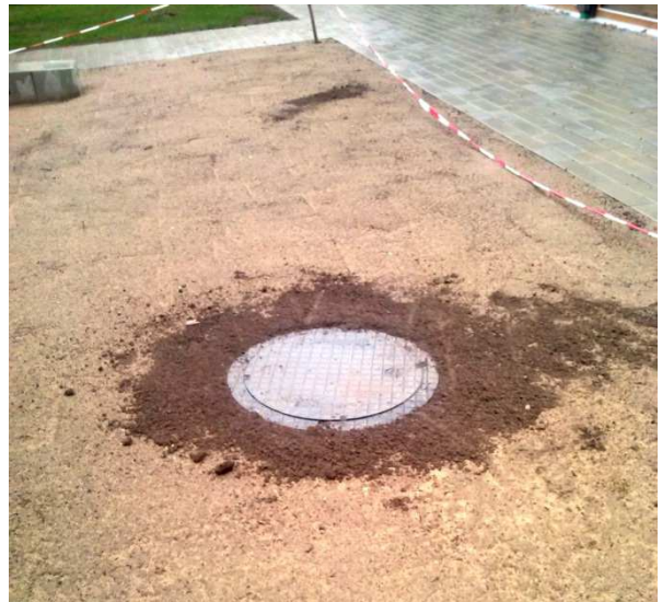
Abb. 6: Sauberer Abschluss des Schachtdeckels mit der Geländeoberkante
