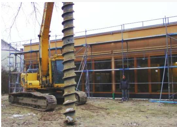
Abb. 1: Hohlschneckenbohrer am Bagger
