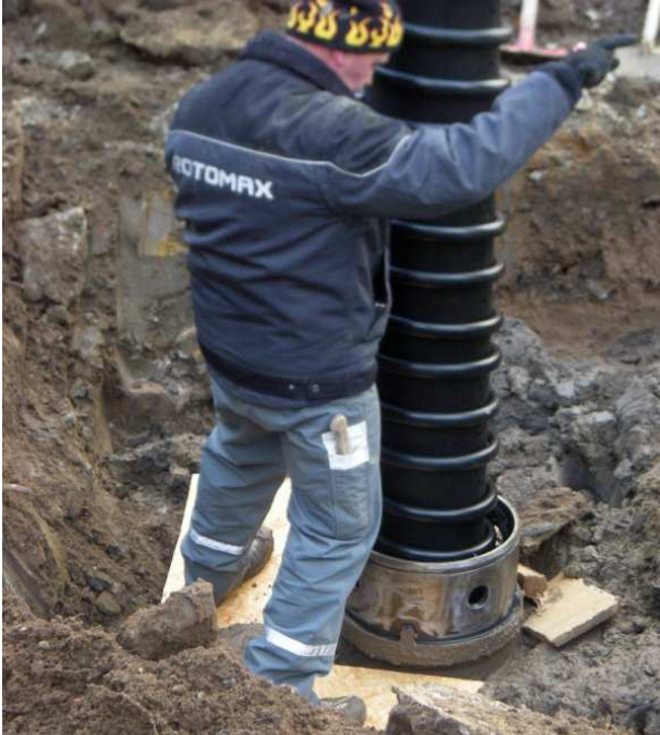
Abb. 4: Einbau des VTP in den Hohlbohrer
